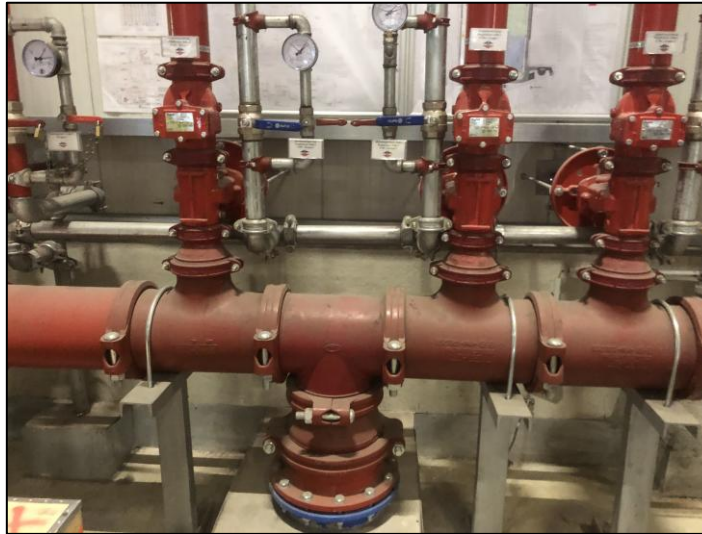
Anschluss Regalsprinkler
